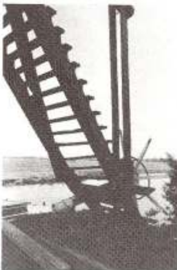
De "staart" van de molen met onderaan het kruiwiel waarmee de molen door middel van een ketting op de wind kan worden gezet
