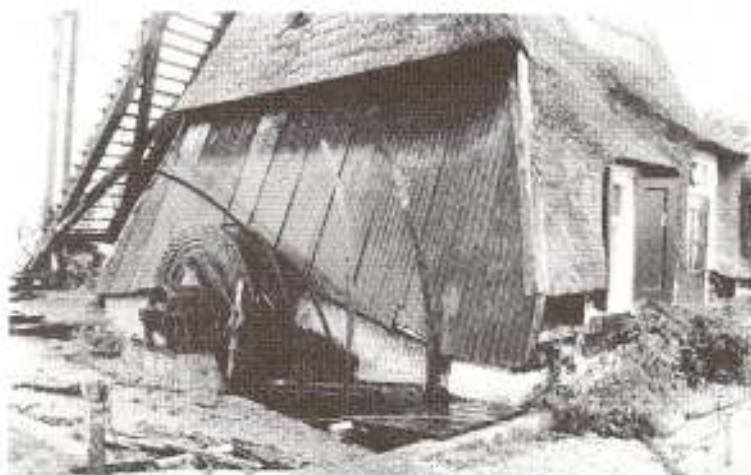
Het inmiddels gedemonteerde scheprad dat ook gedeeltelijk zal worden vernieuwd
