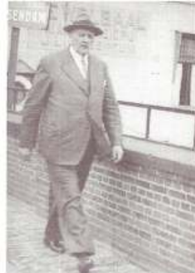
Koos Langedijk wandelt over de sluis op den Dam.
