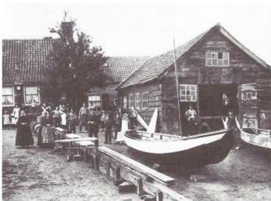
De plaats waar deze foto is gemaakt is onlangs zo rigoureus veranderd, dat het allerlaatste spoor van de bekende werf van Van der Hoff, voorgoed is verdwenen.
