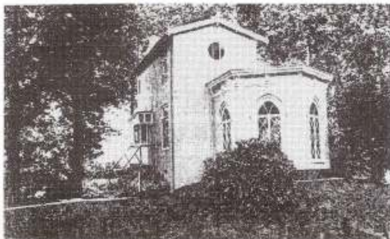
Ir. Arie C. van der Meijden ontving de Jubileum Restauratieprijs voor Zuid-Holland voor de restauratie van deze koepel met later aangebouwd huis in Hardinxveld
