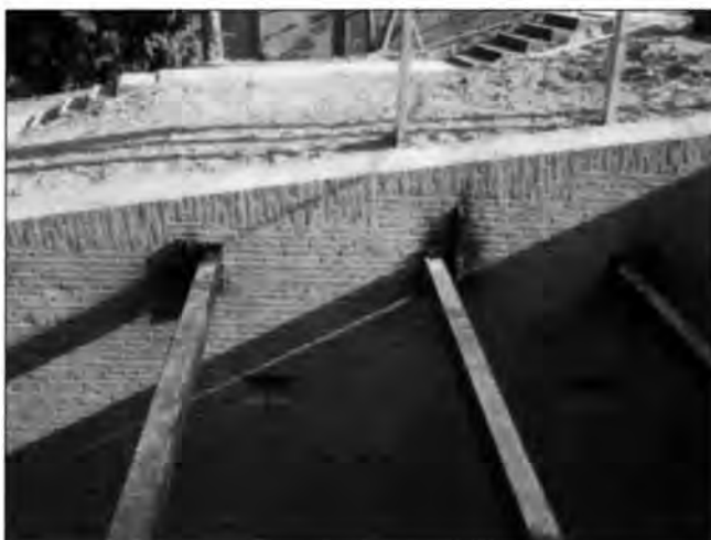
De nieuwe stalen balken
