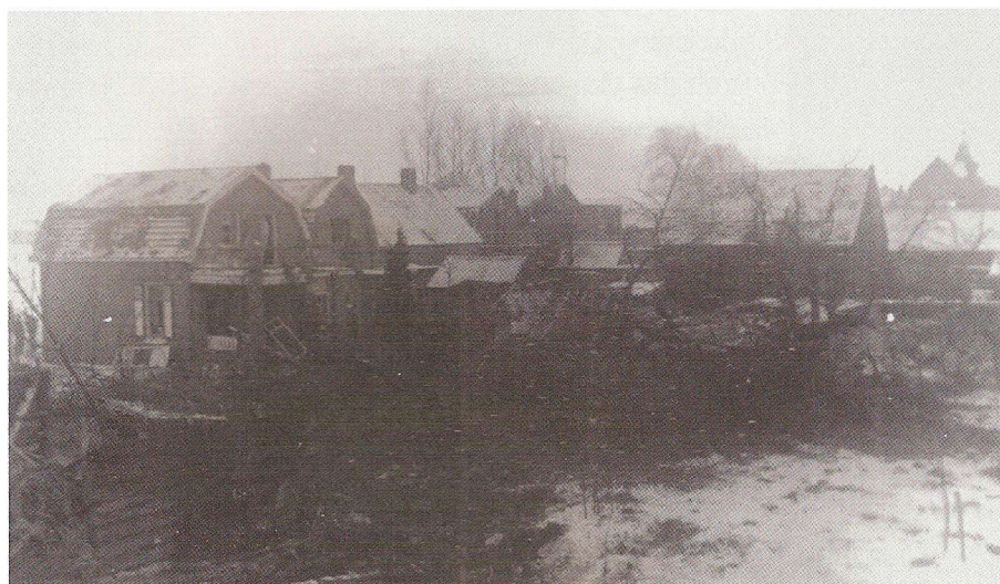
De achterzijde van de woningen Achterdijk 68, 66 en 64.
