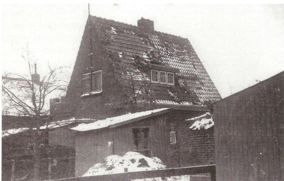
De achterzijde van de woning Achterdijk 70, ontworpen door architect Marius Donk in opdracht van J.Boom. Bouwjaar 1933.
