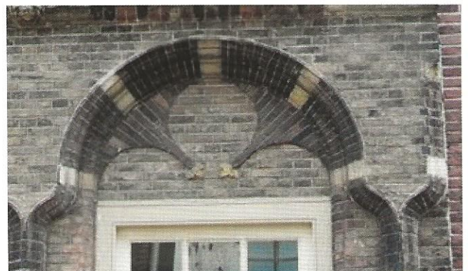
Detail meesterlijk metselwerk Dordrecht
