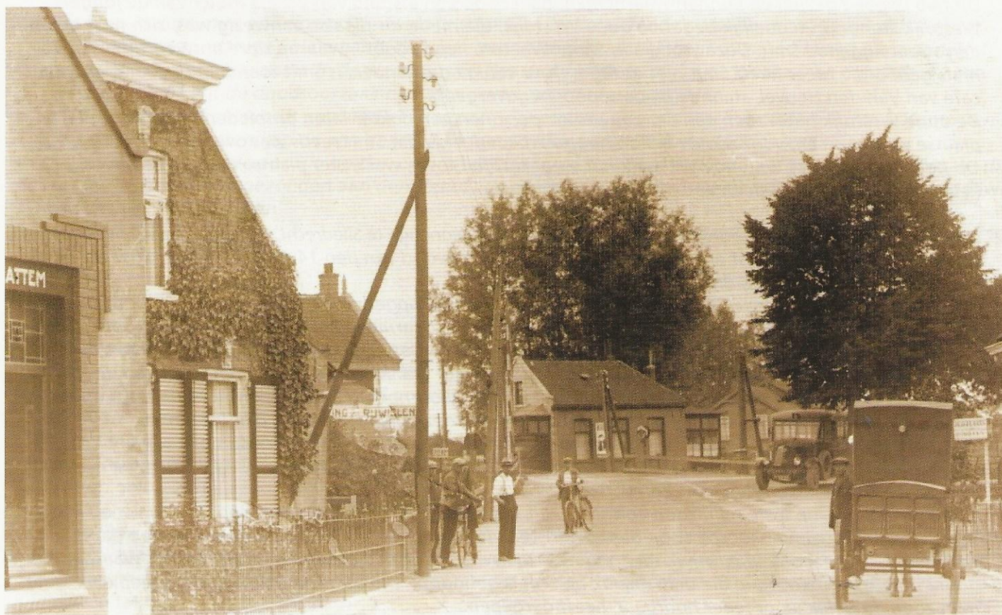
Gezicht vanuit het toenmalige Binnendams (thans Damstraat) op het café van Van den Heuvel ten noorden van de spoorlijn, met links ervan nog zichtbaar een slagboom van de spoorwegovergang en links daarvan, op deze oude foto niet zichtbaar, het station aan de zuidzijde staande. In het midden op deze foto moet het schietincident hebben plaatsgevonden. (foto: Archief Hist. Ver. Hardinxveld-Giessendam)
