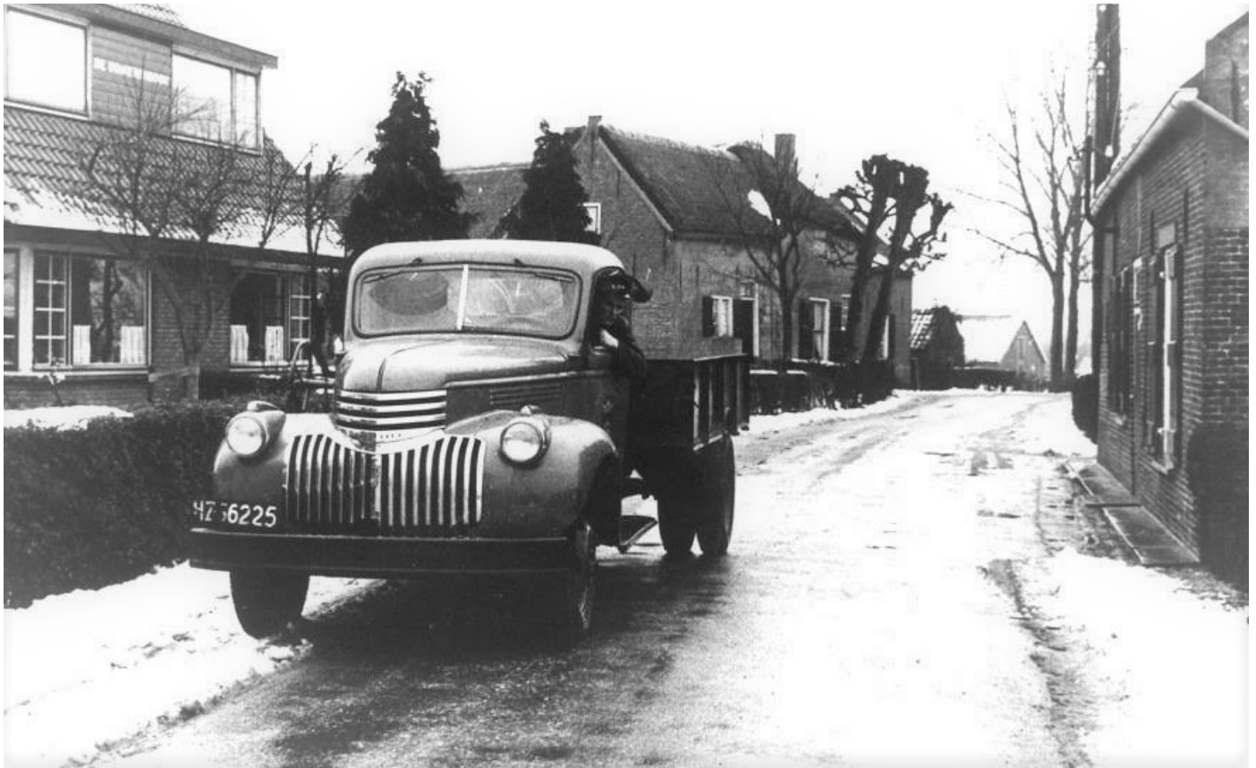
De Chevrolet uit 1947 van de reinigingsdienst. Achter het stuur Teunis Romein. Aan de bijrijderskant van de wagen is de zijstuurinrichting zichtbaar. Plaats: Den Donkeren Boom
