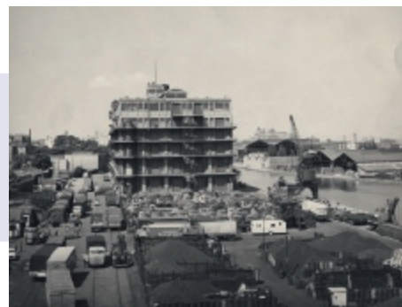
Fig. 8: Magasins Généraux Saint-Denis (bron: Magasins Généraux)
