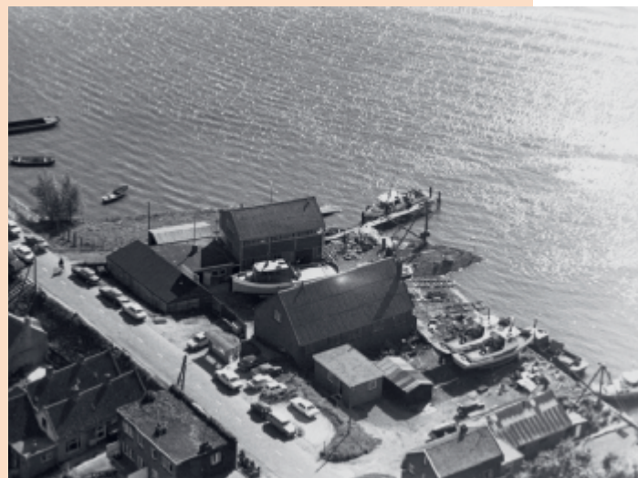
De werf bovenaan de Sluisweg
