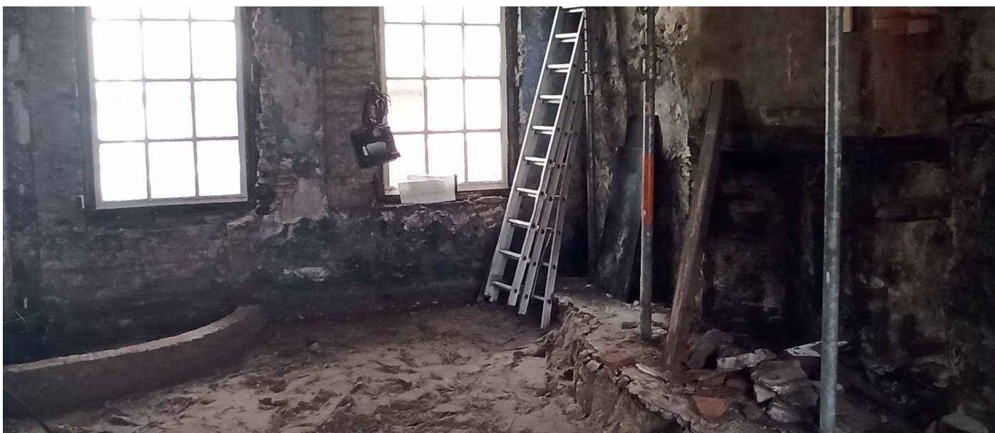
In de linkerhoek een muurtje van onbekende herkomst, dat onder de vloer verstopt zat. Rechts de schouw.
